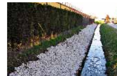
■ Arginatura con pali e ciottolo sullo scolo Rio Fosco, lungo via Boschiera, a Piazzola sul Brenta località Boschiera;
