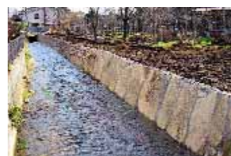
■ Ricalibratura e protezione sponde torrente Ghebo Longhella, a Mason Vicentino;
