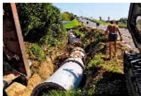
■ sistemazione della roggia Gò a San Pietro in Gù;
