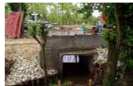
■ Ricostruzione ponticello sullo scolo
