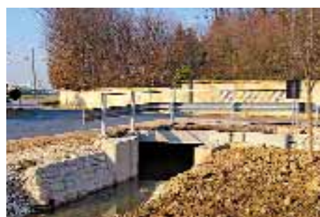
■ rifacimento dell'attraversamento di Giarabassa della roggia Mattarella a Gazzo;
