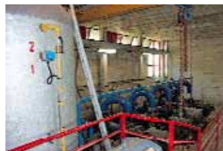
■ ristrutturazione idraulica della centrale di Camisano Vicentino con sostituzione di n° 3 elettropompe e del sistema di automazione;
