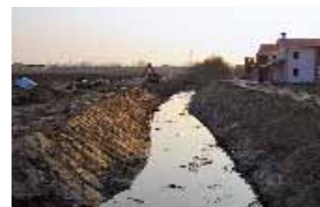
■ Risezionamento con realizzazione di presidi di sponda su scolo Rio Porra a Limena;
