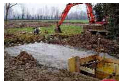
■ Rifacimento ponte in attraversamento di via Roncaglia di Sotto sul bocchetto Peron a Schiavon;
