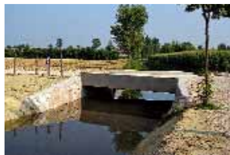
■ rifacimento di un ponte sul rio Fosco a Villafranca;
