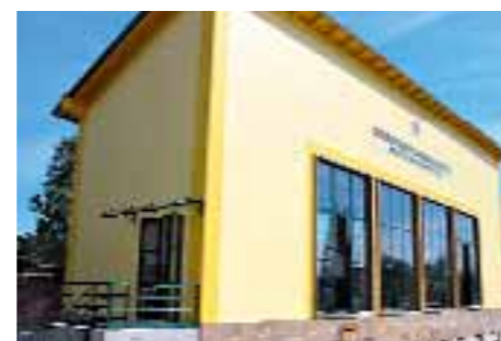
■ ristrutturazione edile dell'idrovora di Brentelle a Padova con sostituzione della lastra di copertura del tratto con eternit ondulato in lamiera, sostituzione dei serramenti e vetrate, tinteggiatura;
