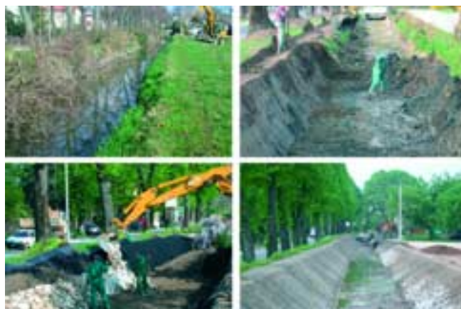
figura 13 Sistemazione Roggia Cappella.
