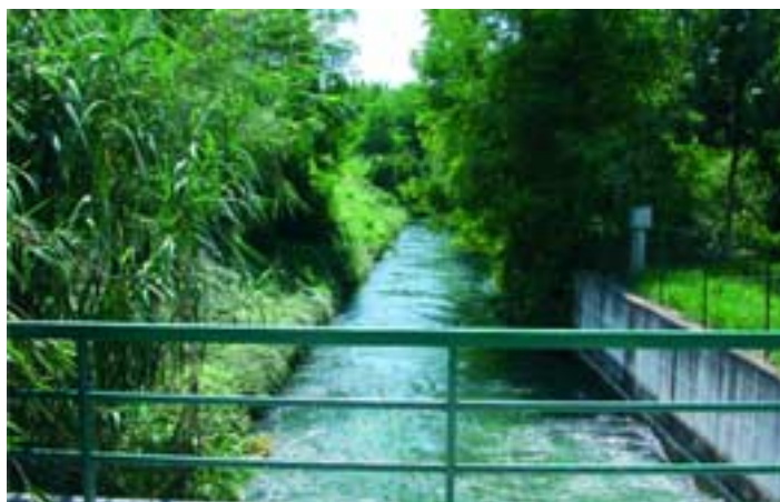
figura 59 ————— Roggia Dolfina alla presa dal canale Medoaco
