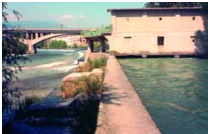
figura 51 Presa canale Medoaco a Bassano
