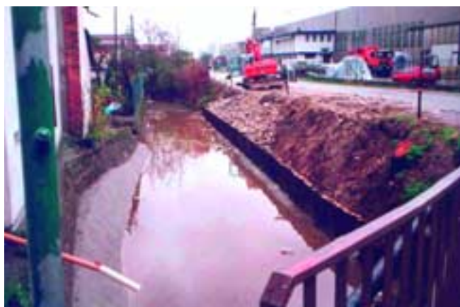
figura 8 ————— Rifacimento argine roggia Dolfina, Rosà
