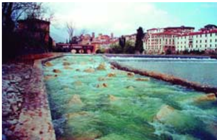
figura 50 Scala risalita ittica sul Brenta a Bassano
