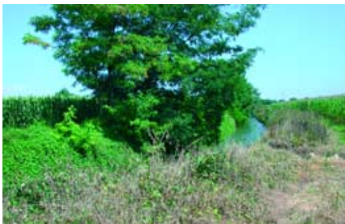
figura 67 — Roggia Dolfina a valle della presa Morosine a Cartigliano
