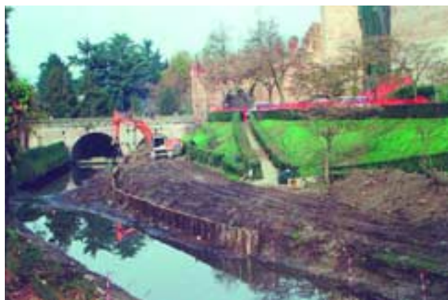
figura 15 Sistemazione fossato delle Mura di Cittadella
