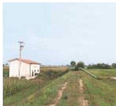
Idrovora Fratta a Veggiano
