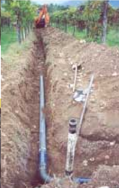
(O) Realizzazione di un impianto di irrigazione in pressione nell'area didattica dell'Istituto di Agraria "A. Parolini" di Bassano del Grappa
