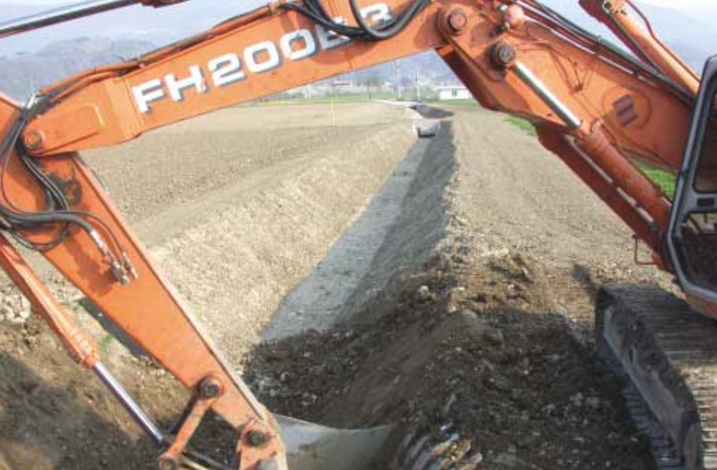
Lavori di un nuovo tratto del torrente Silanello a Marostica
