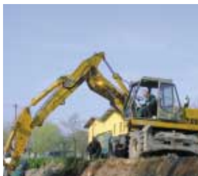
Lavori di sistemazione roggia Cappella Brentellona a Galliera
