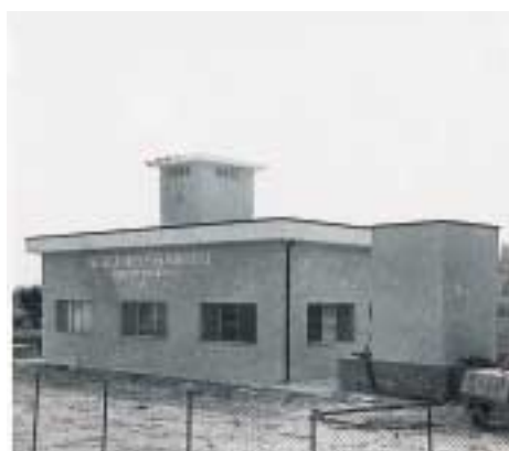
Impianto pluviirriguo di Marostica
