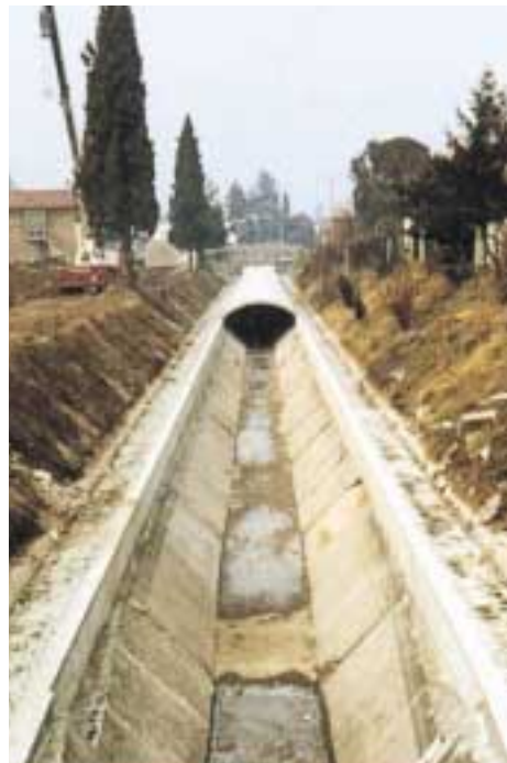
Sistemazione del canale Tronco Alto a Bassano
