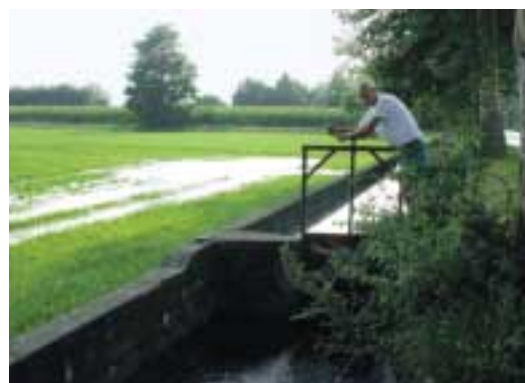
Manovra di una paratoia
