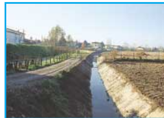
Descrizione: ricalibratura di un canale consortile, non più sufficiente a seguito delle urbanizzazioni. Inizio lavori: 26 aprile 2001; fine lavori: 4 gennaio 2002.
