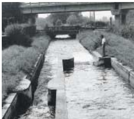
Misuratori di portata sul canale unico a Bassano
