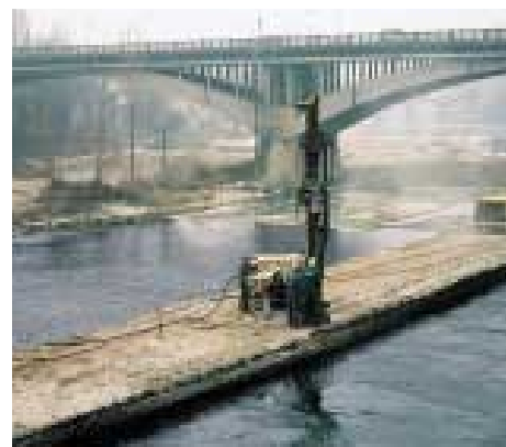
Sistemazione traversa sul Brenta a Bassano
