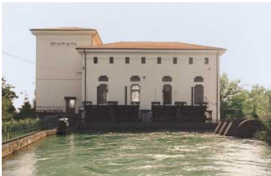
Centrale idroelettrica di S. Lazzaro, acquistata dall'ex consorzio "Irrigazione Brenta"
