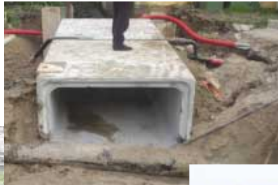
(H) Rifacimento del ponte sulla roggia Learda in via Ca' Bianca di Gazzo
